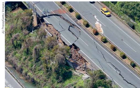
Estragos provocados em uma estrada no Japão, pelo terremoto que atingiu o país em 2021. Felizmente, tremores de terra de grande magnitude são raros no Brasil.
